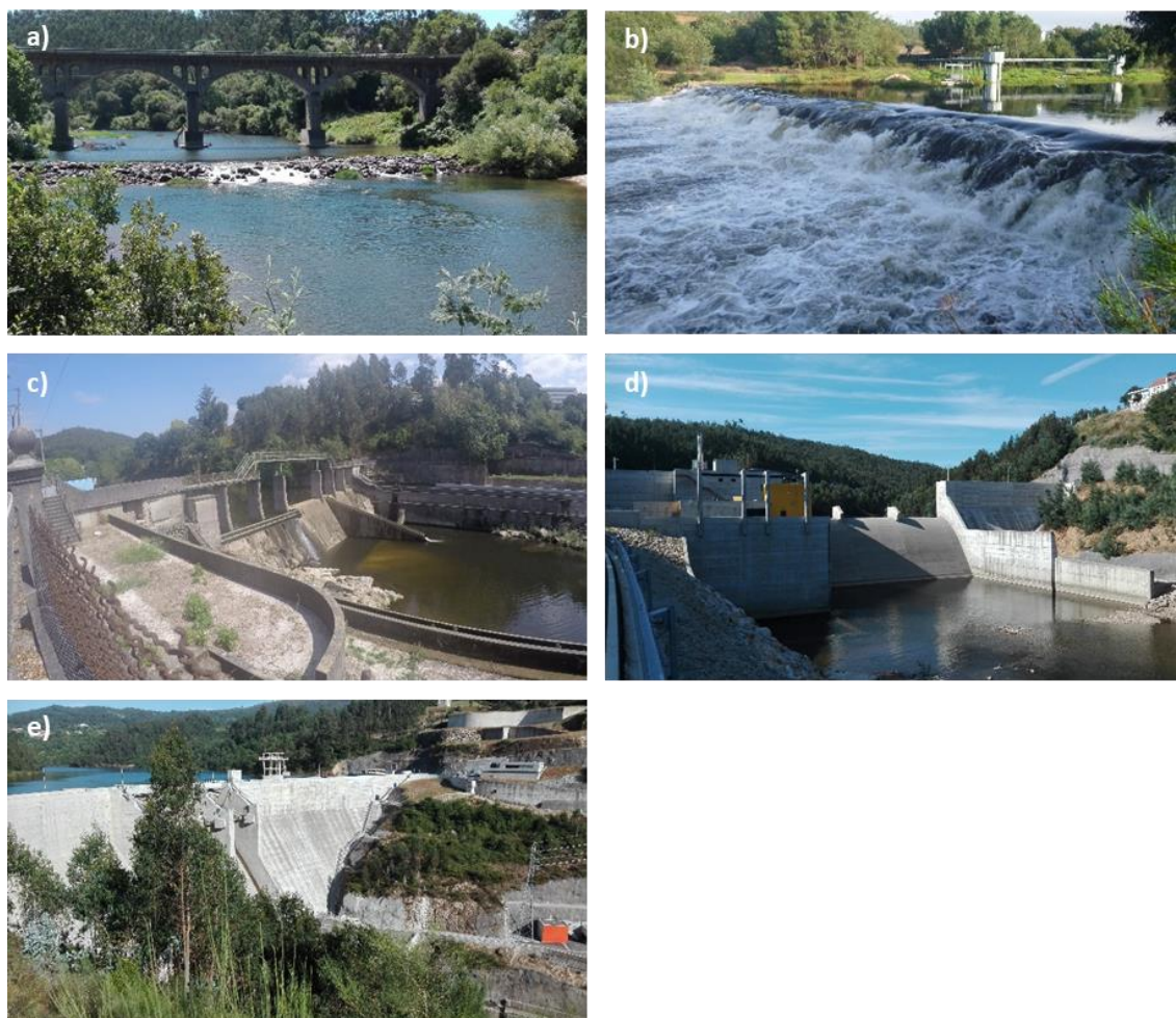
Figura 2 – Infraestruturas hidráulicas presentes no troço inferior-intermédio do rio Vouga: açudes de Sernada (a) e Carvoeiro (b); Aproveitamento Hidroelétrico da Grela (c); Aproveitamento Hidroelétrico de Ribeiradio-Ermida: barragens de Ermida (d) e Ribeiradio (e).
